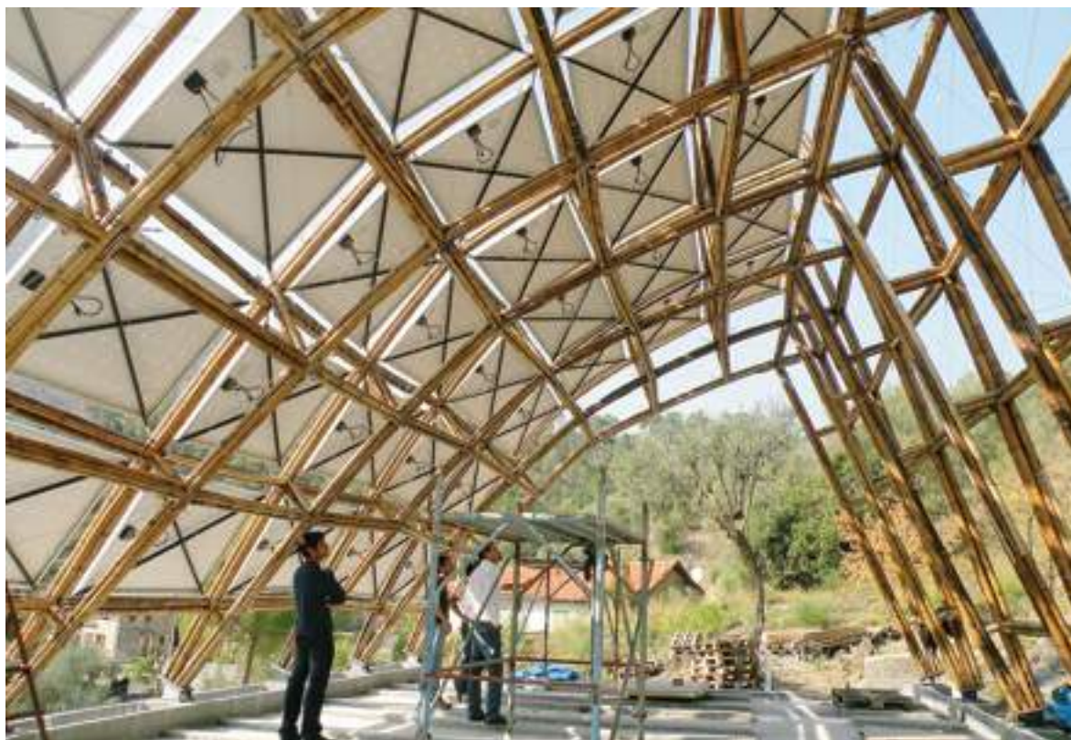
La realizzazione di un padiglione a Settimo Torinese con la struttura in bambù
