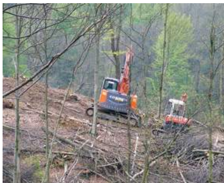
Una fase dei lavori di disboscamento al Giovo
